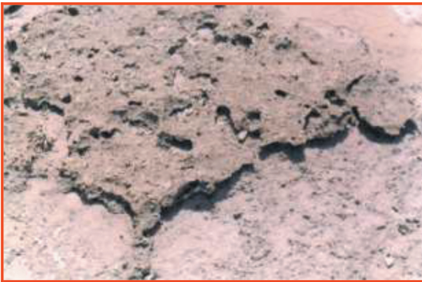
صورة (٤) عملية التخفيض الراسي لسطح أحد أرصفة الشاطئ على الساحل الشرقي لخليج زكريت، كما تنتشر فوقه بعض الحفر الصغيرة والتي قد تلتحم مكونة حفر أكثر اتساعاً فيما يعرف بعملية حفر الشاطئ.
