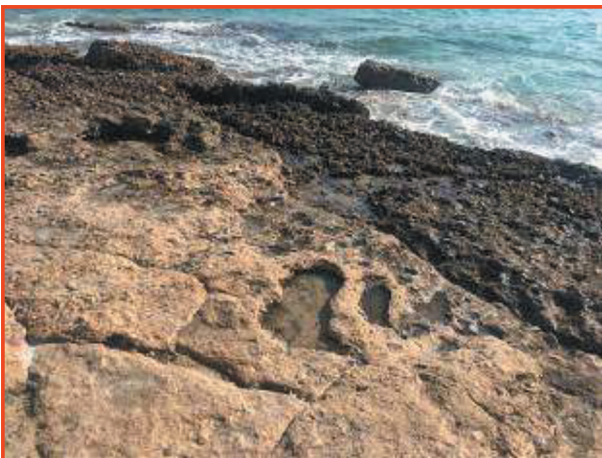
صورة (١٦) برك إذابة صخرية، وفواصل بنيوية على أحد أرضفة الشاطئ على الساحل الشرقي لرأس أبروق. ويلاحظ امتلاء البرك بمياه الأمواج. التصوير: جهة الشرق.
